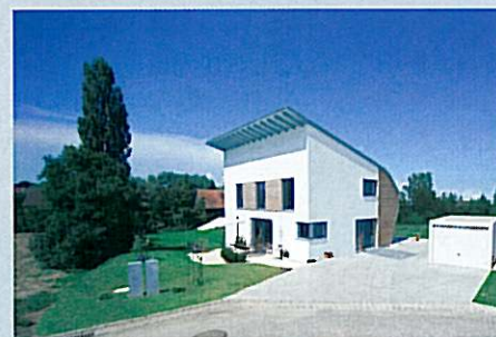
Das „Reatherm-Haus“: ein innovatives Baukonzept mit doppelter, luftdurchströmter Außenschale zur Minimierung von Transmissionswärmeverlusten.
